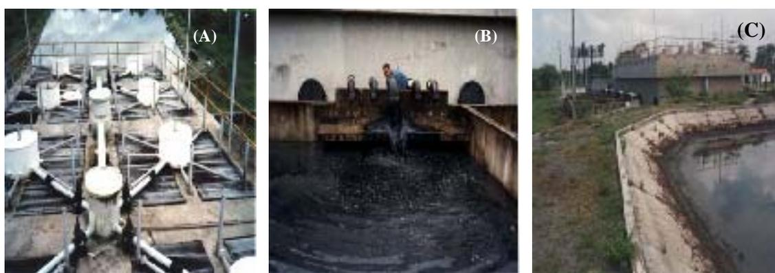
**Figura 3.5** – Vista superior do reator UASB e da lagoa de polimento da ETE Mangueira (A), tubulação de tomada do lodo de excesso do reator UASB (B) e do local de amostragem na lagoa de polimento (C).
