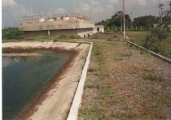
**Figura 2.5** – Lodo na parte superior da lagoa de polimento da ETE Mangueira.
