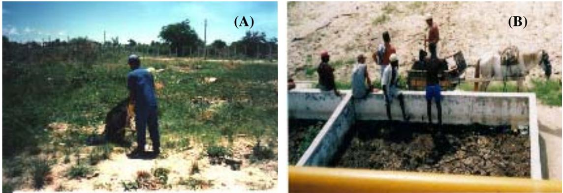
**Figura 2.4** – Disposição dos resíduos sólidos no terreno da estação (A) e remoção do lodo desidratado em leito de secagem por moradores próximos da ETE Mangueira (B)
