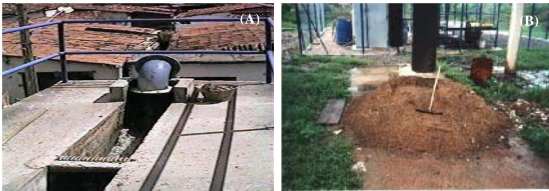
**Figura 2.2** – Resíduo removido da grade da ETE Vila São João (A) e areia removida na limpeza da caixa de areia da ETE Mangueira (B).
