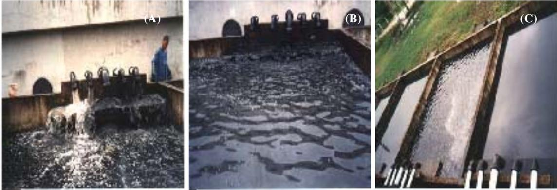
**Figura 5.6** – Vista das tubulações de descarte de lodo de excesso do reator UASB nos leitos de secagem da ETE Mangueira (A), Vista da altura de lodo descartado no leito de secagem (B) e Vista superior dos leitos de secagem de N<sup>o</sup> 1, 3, 5 e 7 após a descarga (C).
