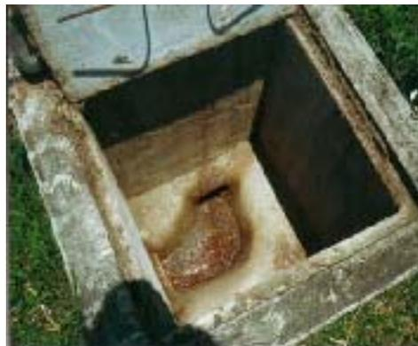
**Figura 5.9** – Caixa de passagem do líquido percolado do leito de secagem
