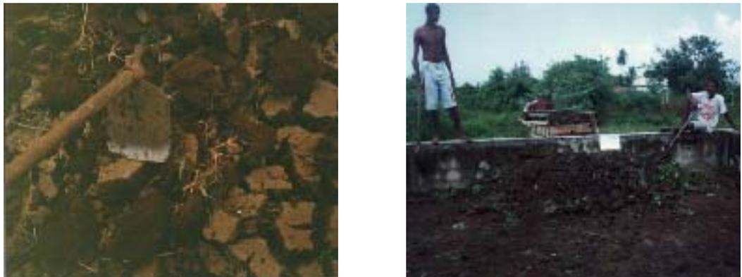
**Figura 5.7** - Remoção do lodo dos leitos de secagem por moradores próximos da estação.
