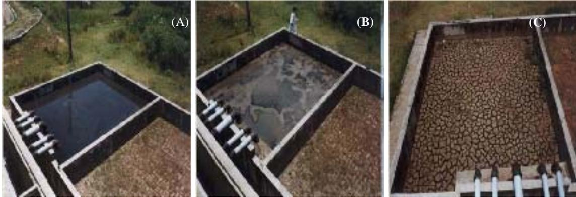
**Figura 5.8** – Vista superior do leito de secagem n°8 da ETE Mangueira após a descarga (A), Vista superior do leito de secagem após dois dias de desidratação (B) e Vista superior do leito de secagem após sete dias de desidratação (C).
