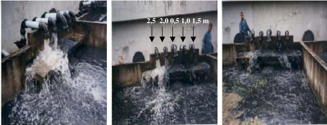
**Figura 4.3** – Pontos de amostragens do lodo de excesso a 2,5; 2,0; 1,5; 1,0 e 0,5m de altura da parte inferior do reator UASB
