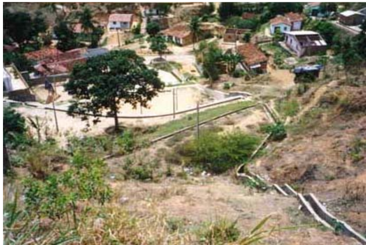
Foto IV.5 – Reabilitação da encosta S, córrego do Boleiro.
