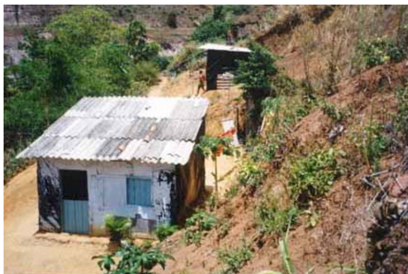
Foto IV.2 – Construção de casas próximas aos taludes.
