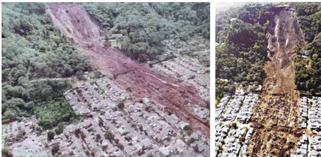
Foto II.1 – Escorregamento em El Salvador na cidade de Comasagua, DPNET (16/01/2001) e KINGSCASTLE.
