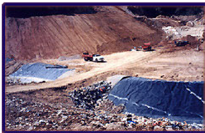
Figura 4.4 – Aterro sanitário da Extrema (Fonte: Departamento de Limpeza Urbana de Porto Alegre, 2002)
