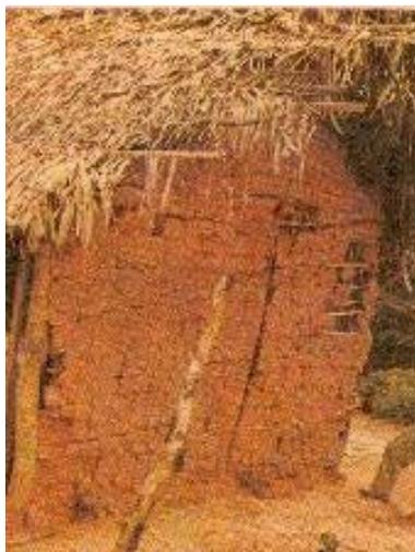
Figura 1.3 – Construção de alvenaria em taipa de mão.
