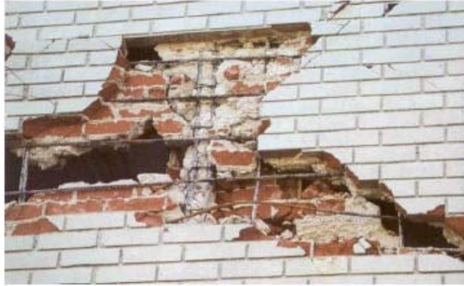
Figura 2.3 – Detalhe de alvenaria estrutural armada que sofreu colapso. Observe a presença de armaduras horizontais e verticais, estas preenchidas por graute.
