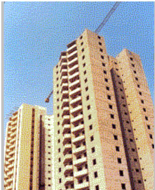
Figura 2.5 – Edifício em alvenaria armada com blocos vazados de concreto.
