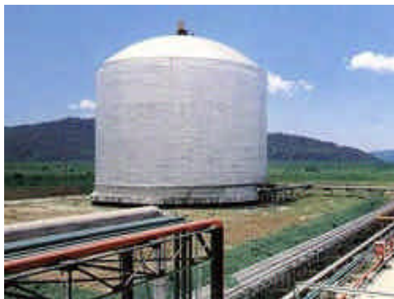
Figura 1.2 - Tanque para amônia líquida. < http://www.ahpes77.hpg.ig.com.Br >
