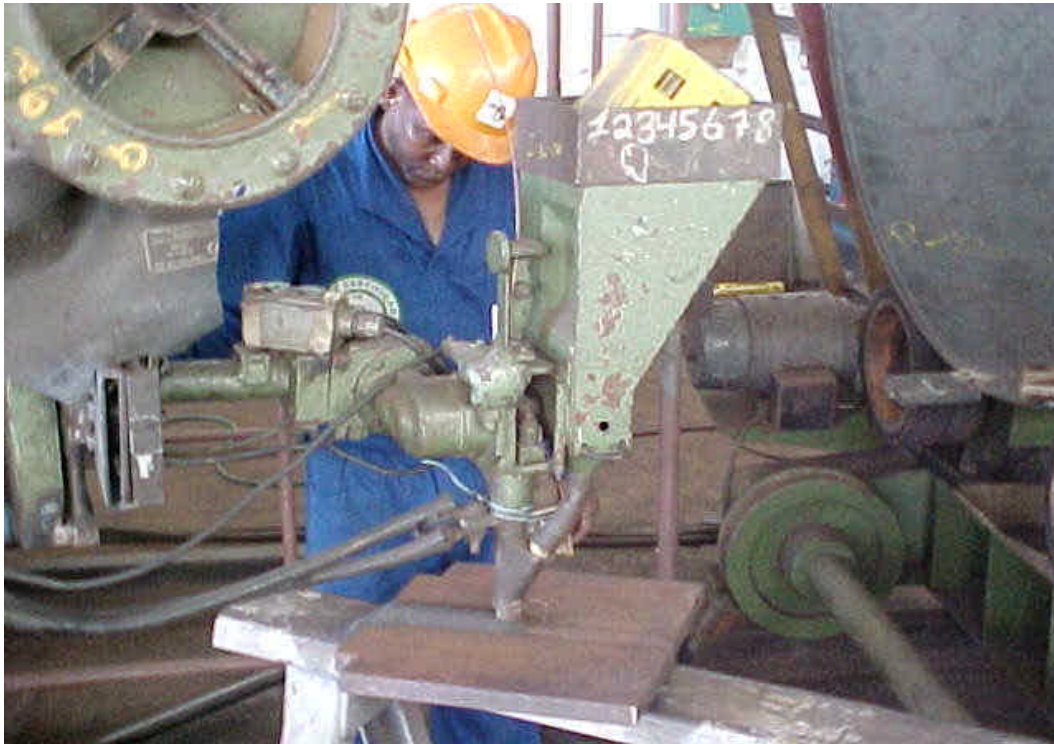
Figura 5.5 – Processo de Soldagem a Arco Submerso: soldagem do corpo de prova em MPN.
