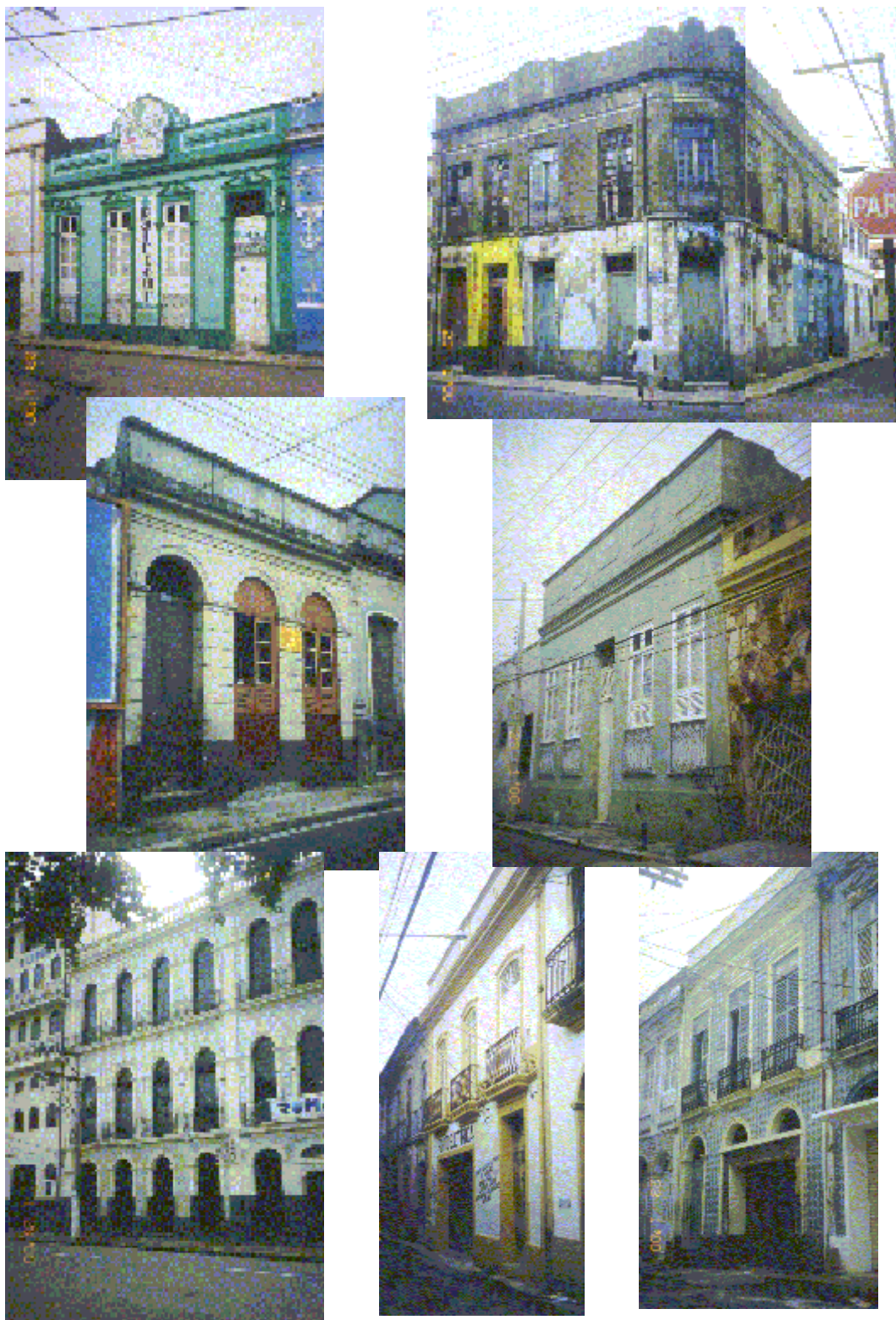
Figuras 97, 98, 99, 100, 101, 102 e 103: Imóveis P.A.P. e R.A.– CH03n264; CH15n234; Ch107n293; CH15n39 CH116n233; CH05n117 e Ch20n316 (sentido horário).
