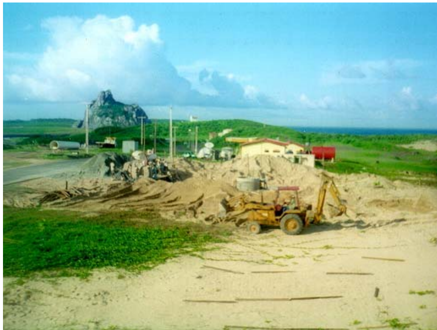
Figura 4. Serviço de escavação e terraplanagem sobre dunas de areia.
