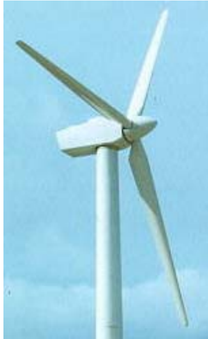
Figura 2.3 – Rotor acoplado à nacelle da turbina eólica de eixo horizontal.
