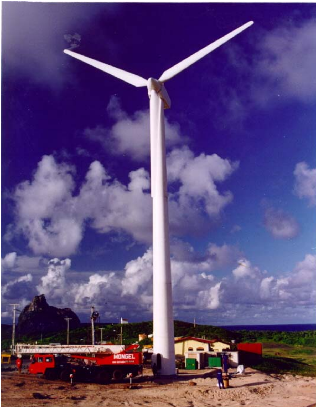
Figura 6.9. Turbina Eólica VESTAS V27–225 kW – instalada na Ilha de Fernando de Noronha.
