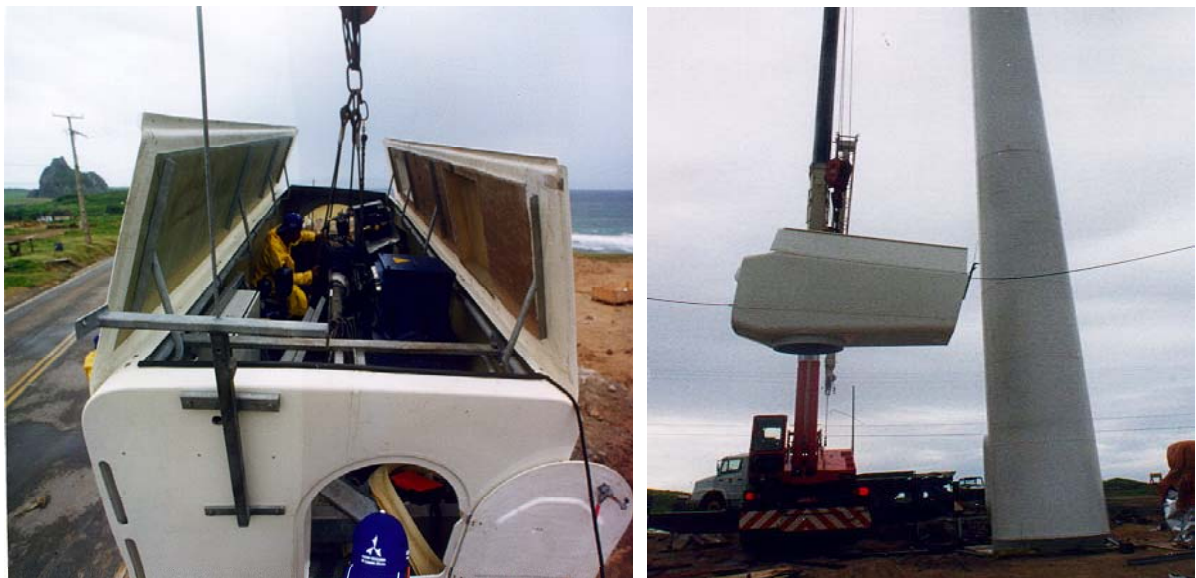
Figura 2.2 – Nacelle de uma turbina eólica de eixo horizontal.
