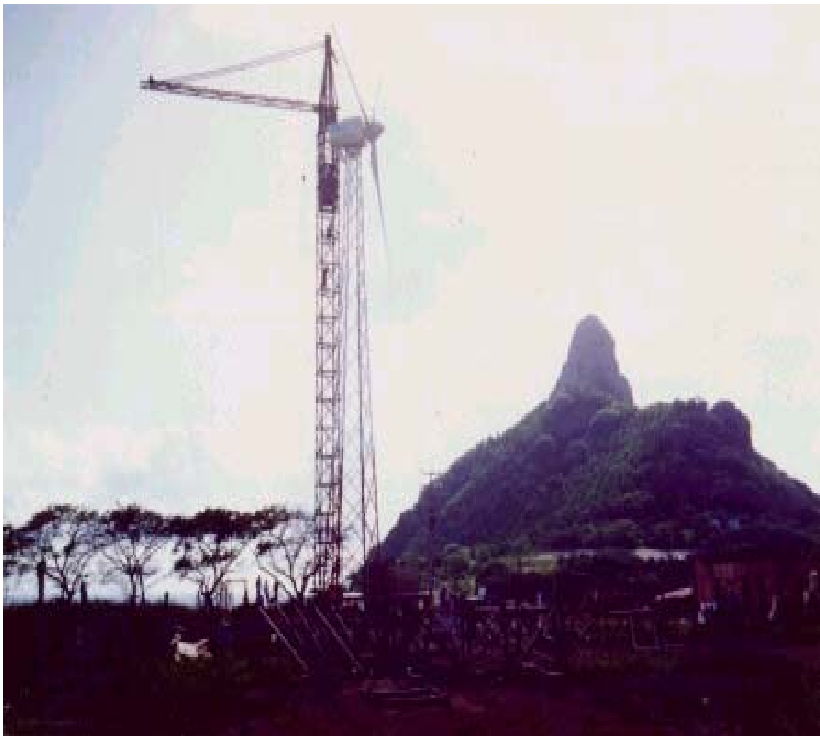
Figura 6.3 - Turbina eólica de 75kW de Fernando de Noronha: potência nominal 75 kW, diâmetro do rotor de 17m e uma torre de 23m de altura.
