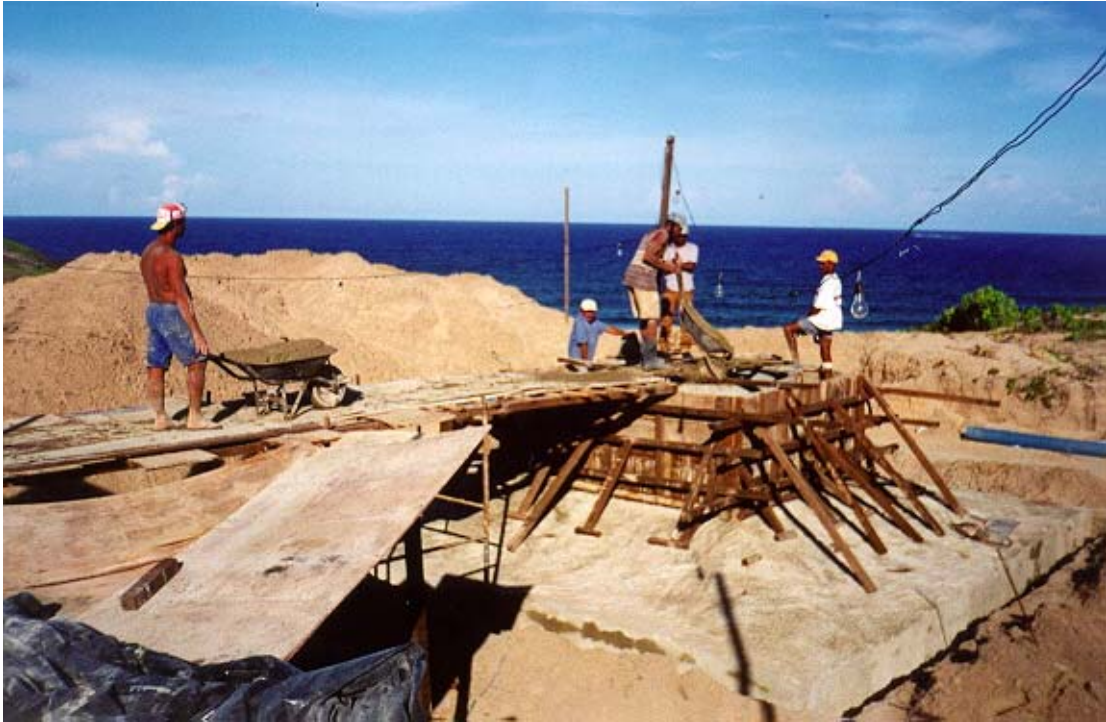
Figura 6. Concretagem da sapata com o suporte cilíndrico de aço da base da turbina.
