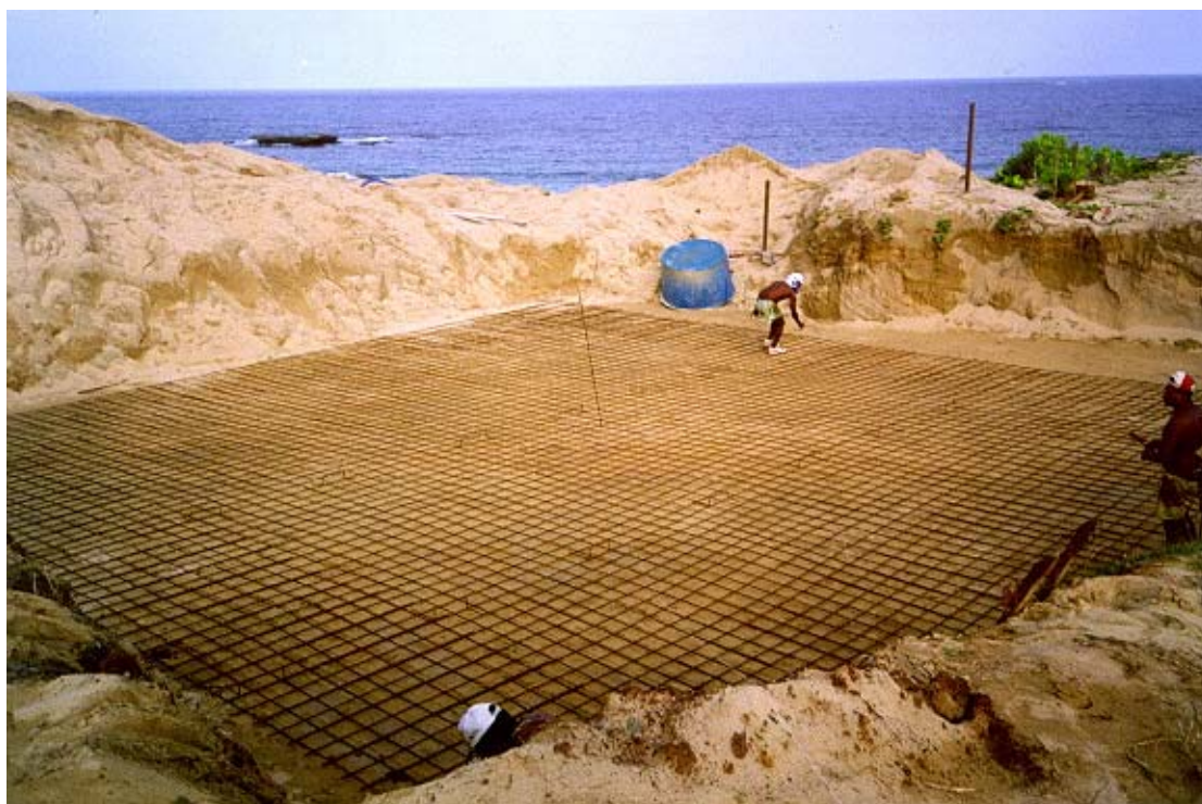
Figura 5. Colocação da malha da laje de 15 cm, sobre o solo compactado.
