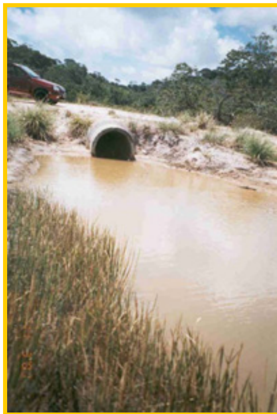
Figura 37 – Tubulação para escoamento da água represada pela estrada em Carneiros, Tamandaré
