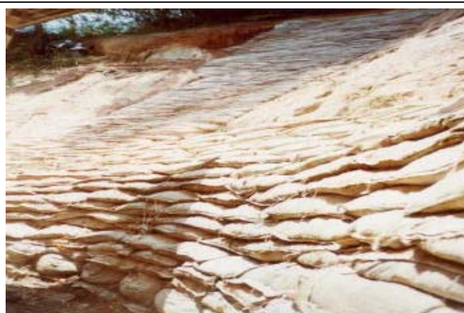
FIGURA 20 - Modelo de intervenção para contenção de escorregamentos.
