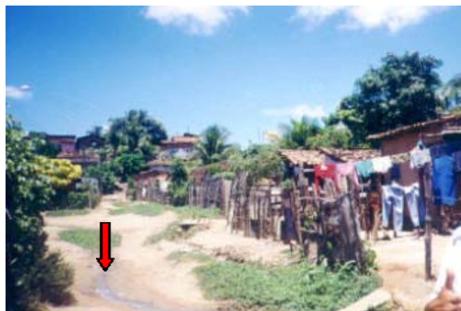
FIGURA 17 - Esgoto a céu aberto em rua do aglomerado Boa Esperança.
