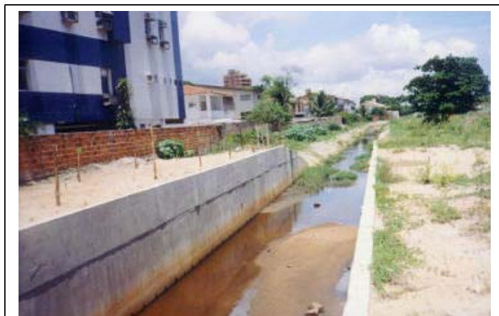
FIGURA 11 - Antigo curso do Rio Jaguaribe, canalizado devido a intensa urbanização do bairro Bessa.
