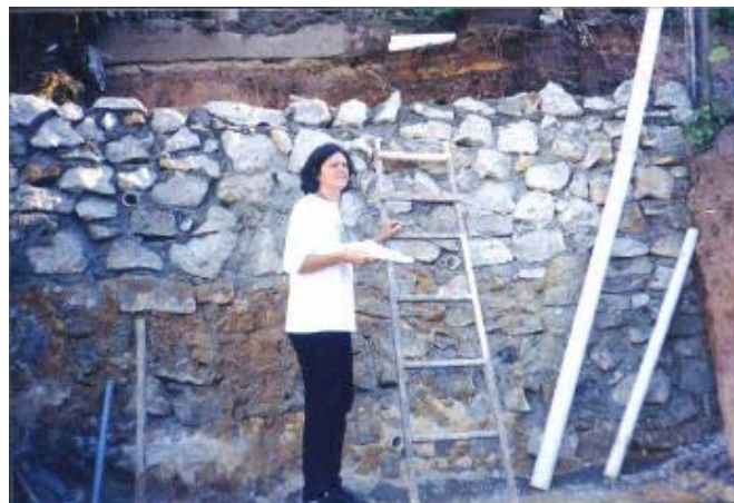
FIGURA 14 - Construção de muro de arrimo no bairro São José.
