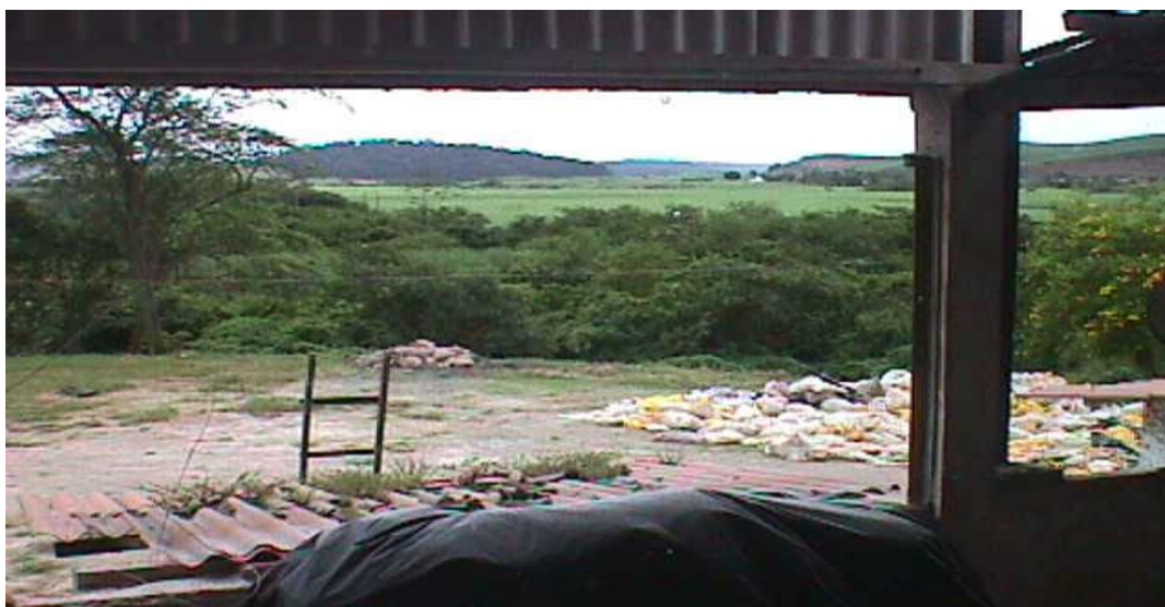
FIGURA 24 – Disposição inadequada de lixo no pátio da usina.
