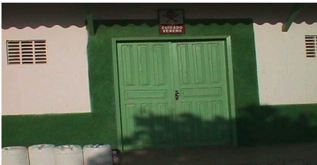
FIGURA 25 – Depósito de Agrotóxicos.
