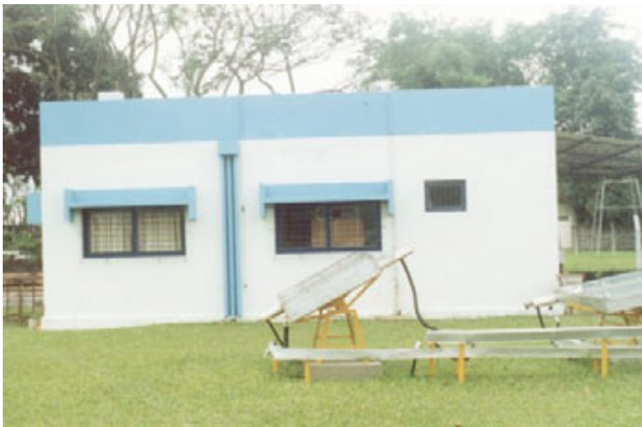
Figura 3.4 Fachada OESTE do laboratório utilizado para o monitoramento da temperatura interna.
