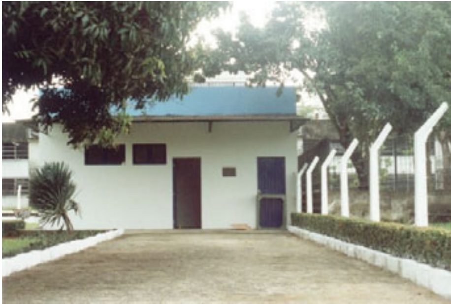
Figura 3.3 Fachada SUL do laboratório utilizado para o monitoramento da temperatura interna.
