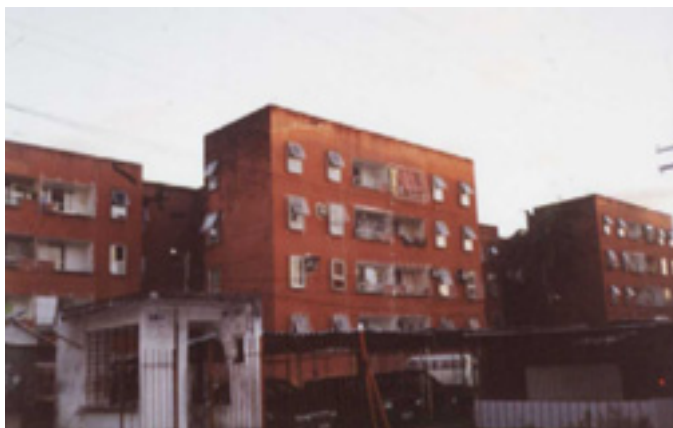
FOTO 6: Guarita Desativada próxima à Rua Ernesto Nazareth
