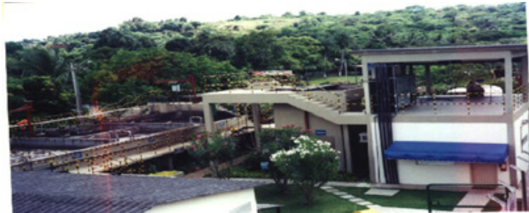
Figura 4.4- Vista geral da ETE
