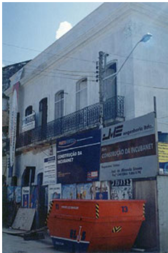
Foto 04 - Obra do Porto Digital – Novembro/2002.
