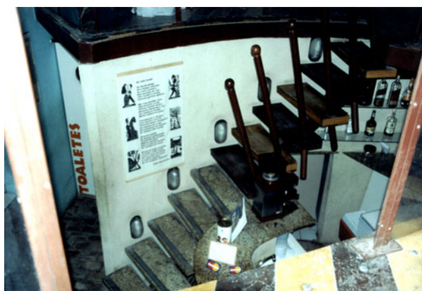
Figura 6.32 – Vista lateral superior da escada de acesso ao mezanino.
