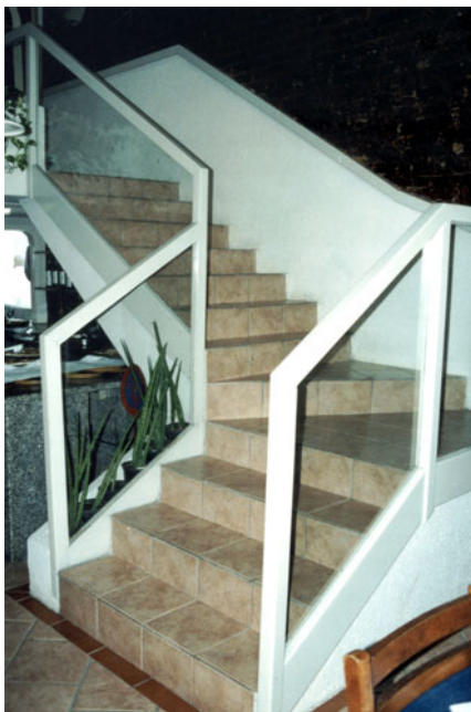
Figura 6.24 – Escada de acesso ao mezanino.
