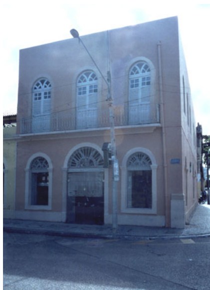
Figura 6.17 – Edifício onde funciona o restaurante “B”.
