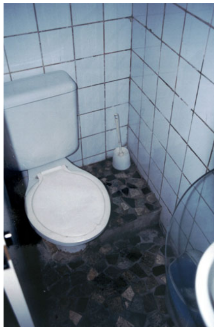
Figura 6.32 – Vistas interna dos banheiros masculino e feminino.
