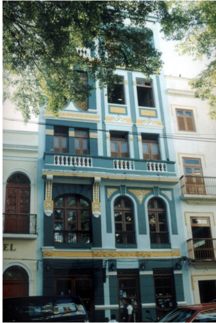
Figura 6.1 – Fachada do edifício ao centro
