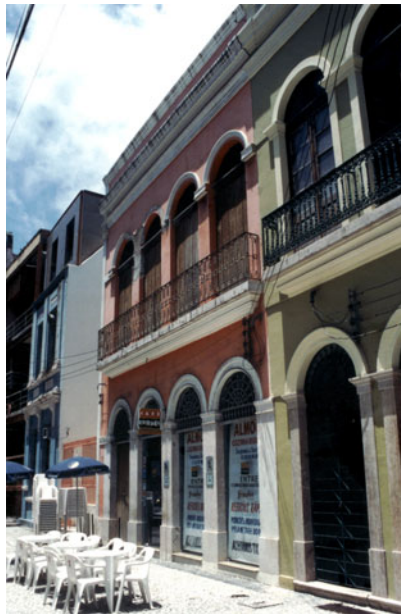
Figura 6.28 – Fachada principal do edifício “C”.
