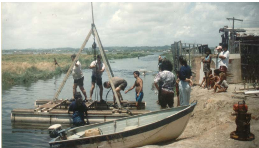
Foto 3.1 – Montagem do “vibro-testemunhador” sobre plataforma flutuante, Lagoa Olho D’água/1992.
