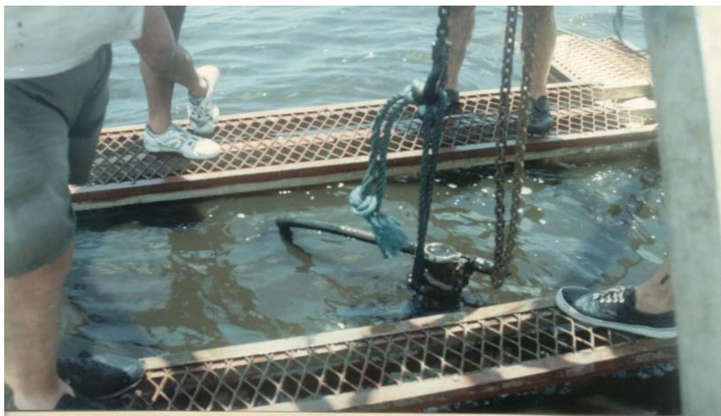
Foto 3.2 – Realização da Sondagem, região central da Lagoa Olho D’água/1992.
