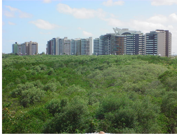
Foto 2.2 Vista do bairro Treze de Julho. Edifícios implantados em área de mangue – solo frágil.
