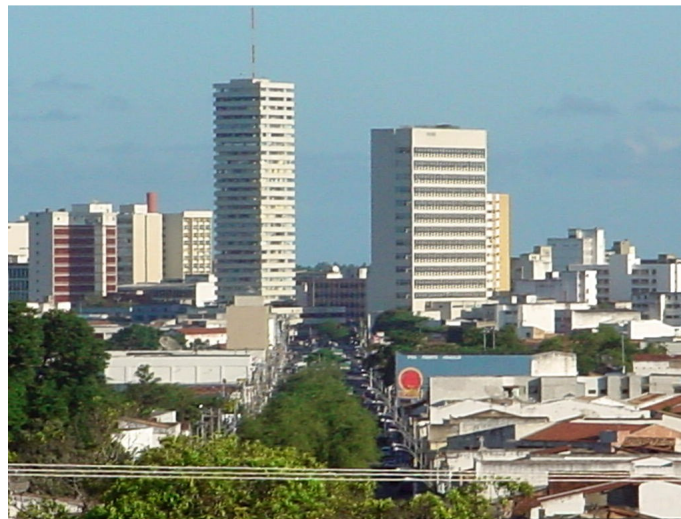
Foto 2.1 Em destaque, da esquerda para direita, o edifício Estado de Sergipe (1970) e o edifício da Previdência Social (1971). Considerados símbolos de progresso e modernidade.
