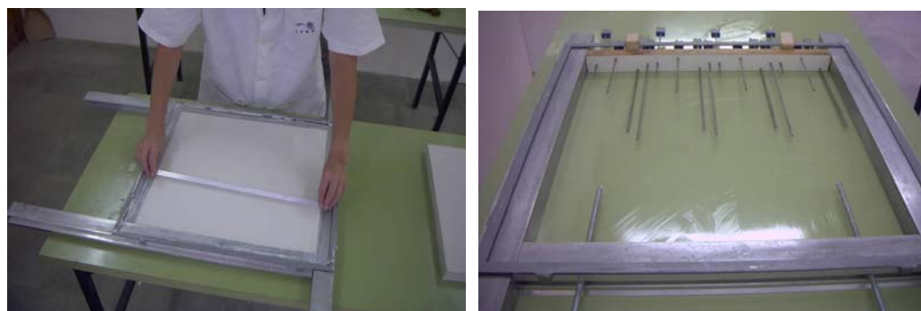
Figuras 4.8 (a e b) – Detalhe das régua para a confecção de placas de gesso e dos elementos de fixação das placas.
