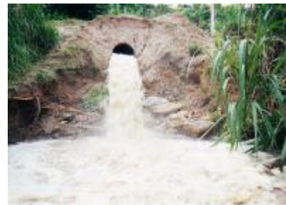
Figura 5.4: Lavagem e descarte da água de lavagem de um filtro da ETA Gurjaú.
