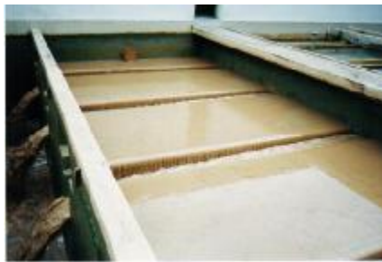
Figura 5.4: Lavagem e descarte da água de lavagem de um filtro da ETA Gurjaú.
