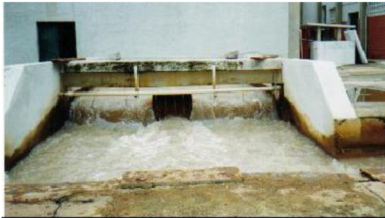
Figura 2.3: Seção de mistura rápida da ETA Gurjaú
