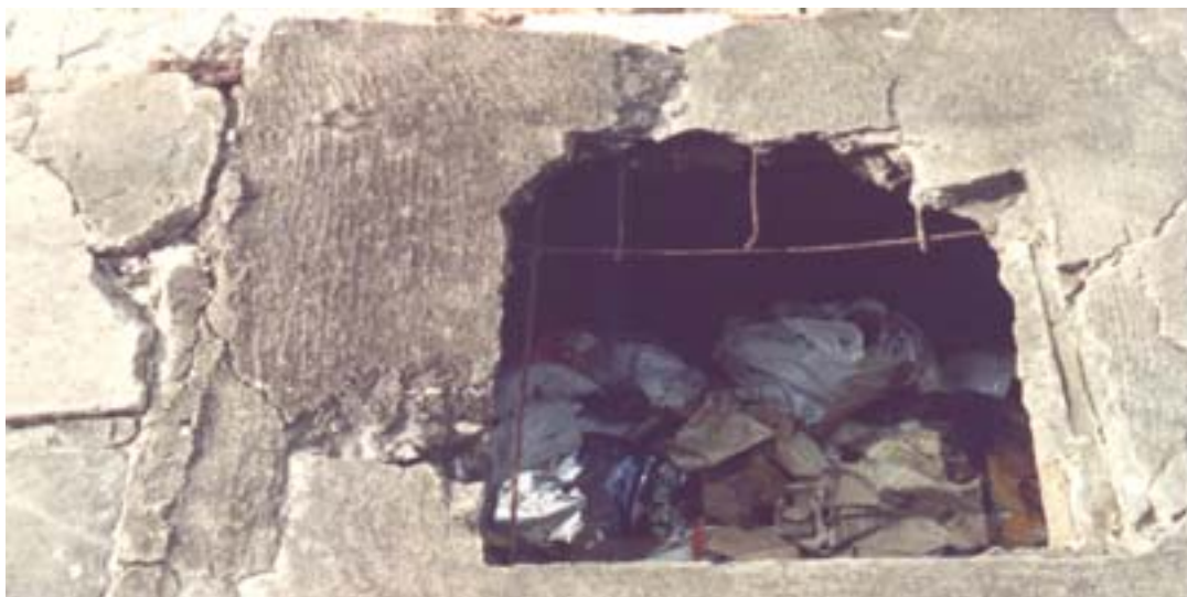
Figura 44 – Lixo em boca coletora - falta de manutenção e educação ambiental. (Olinda, jul/2002).
