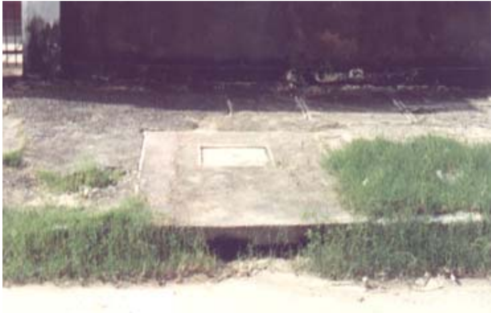
Figura 43- Boca coletora com acúmulo de sedimentos e de vegetação. (Olinda jul/2002).
