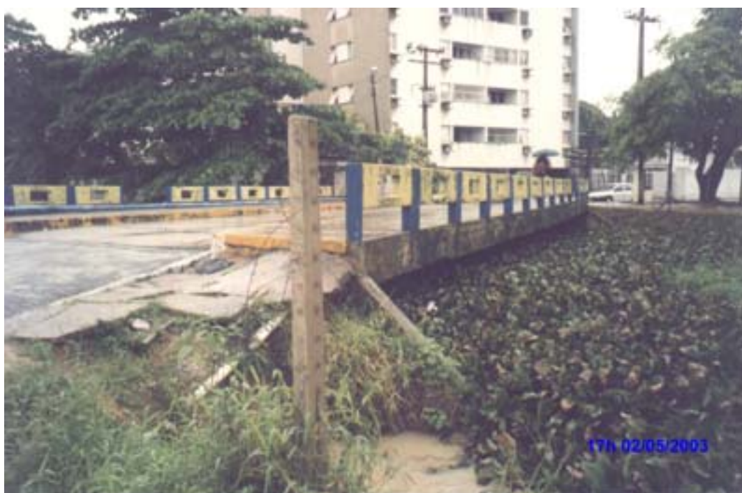
Figura 70 - Ponte sobre o Rio Doce.
