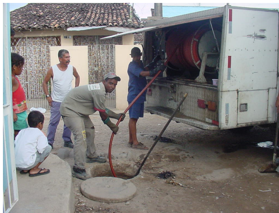
Figura 7.14 - Desobstrução da caixa de passagem, na Mangueira. Recife, 2003
