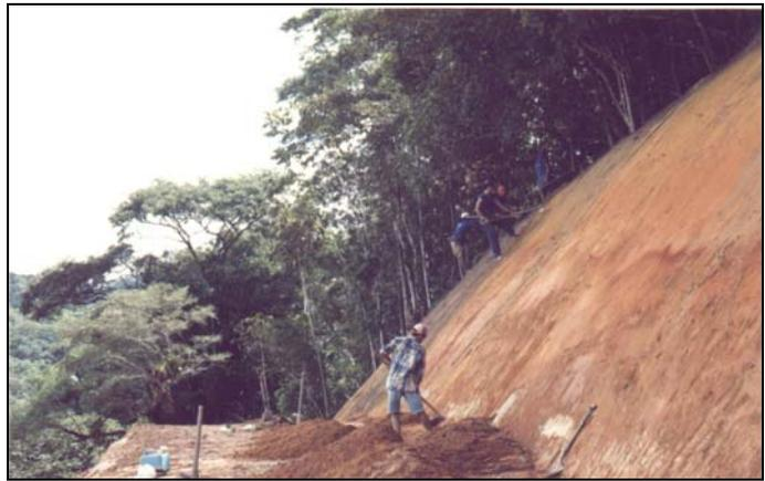
Foto III.16: Retaludamento da Encosta em Patamares
