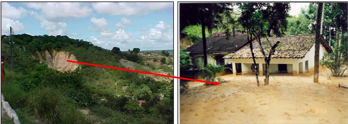
Foto IV.6: Erosão Provocando Assoreamento da Linha de Drenagem
