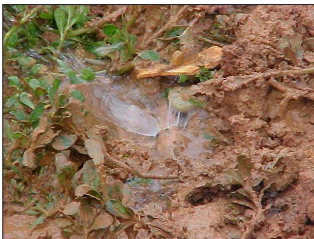
Foto III.9: Tubo da Rede de Água com Vazamento
