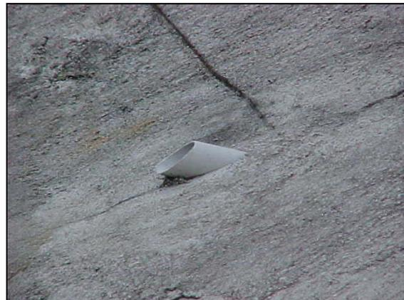
(b) Detalhe dos barbacãs inclinados para cima no talude argamassado
