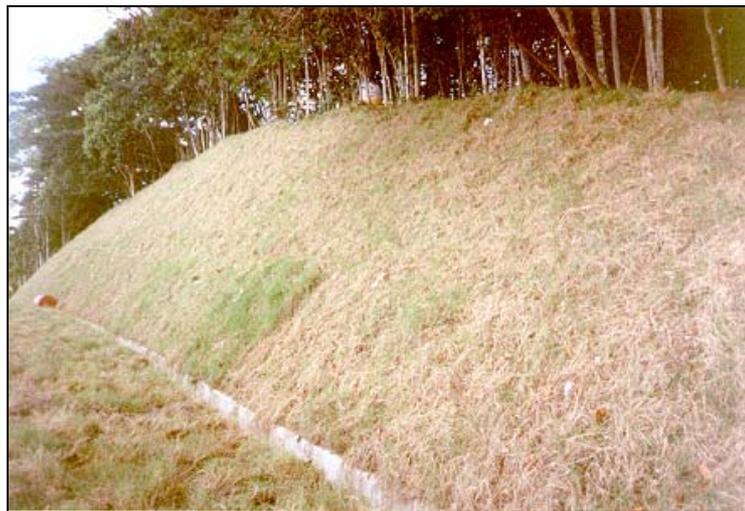
Foto III.17: Patamar Recuperado, com Proteção Vegetal e Micro-drenagem
