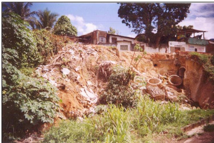
Foto II.2: Erosão Devido a Vazamento de Tubulação de Águas Servidas
