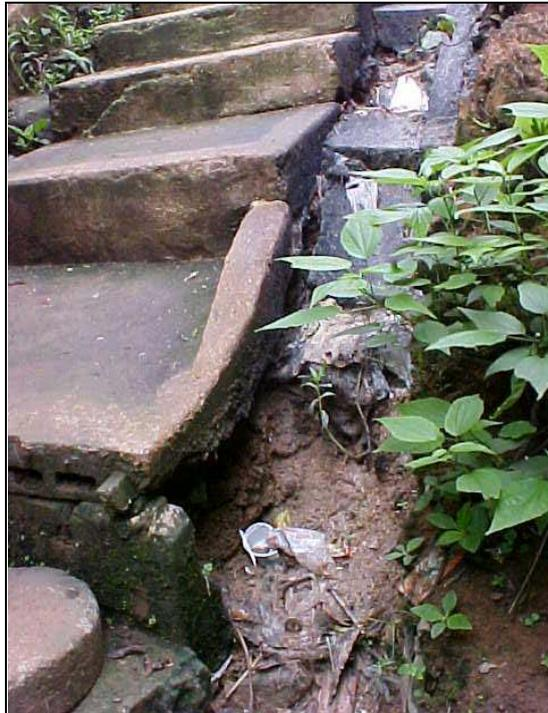
Foto III.1: Canaleta de Descida sem Caixa Coletora
