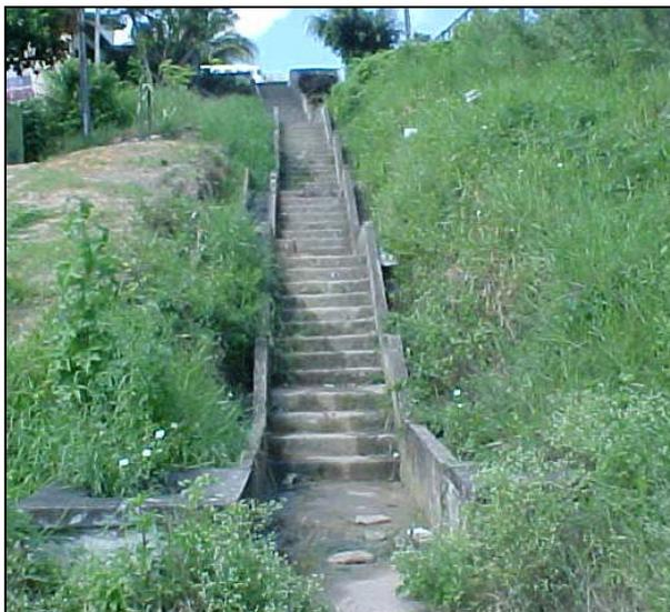
Foto III.8: Escadarias e Canaleta de Descida sem Manutenção
