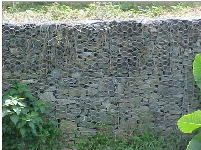
Foto III.11 - Detalhe do Muro em Gabiões
