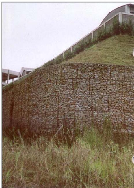
Foto III.10 - Muro em Gabiões (Foto do catálogo Macaferrri)
