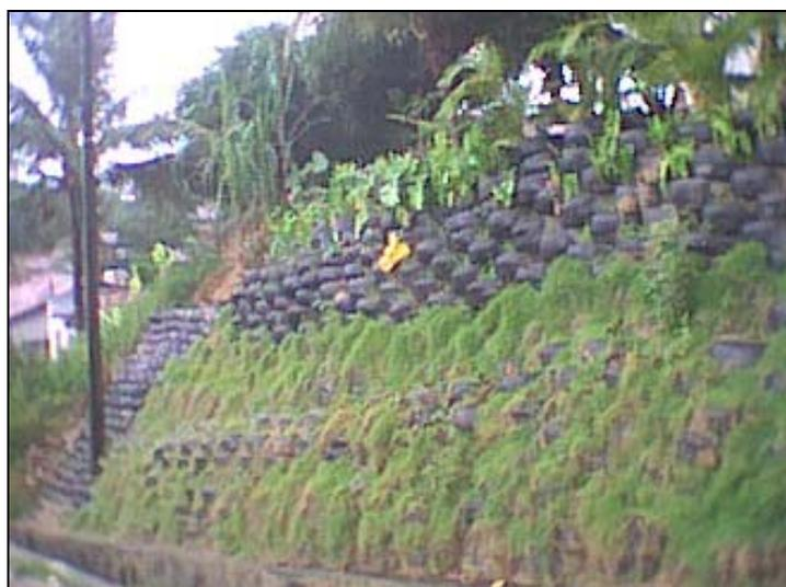
Foto III.13: Muro de Solo-pneus Construído pelo Morador (Ibura – Recife/PE)
