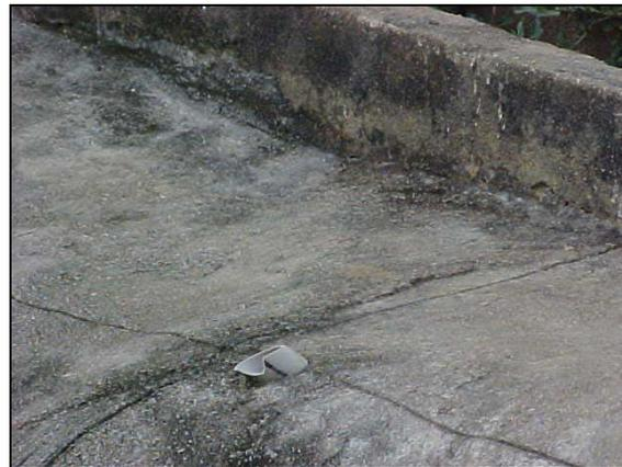
(c) Detalhe dos barbacãs inclinados para cima na crista do talude argamassado
