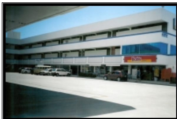
FIGURA 23 – Centro comercial e de serviços, rua Francisco Leocádio Ribeiro Coutinho – Aeroclube. FONTE: João Manoel, Setembro de 2002.
