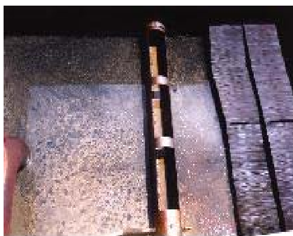
Figura 3.8: Caneletas de separação dentro do SAO.
