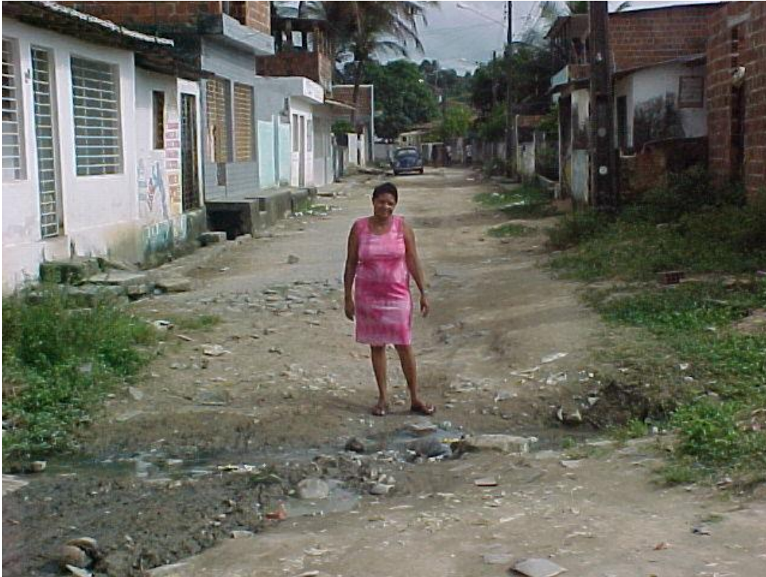
Foto 1 – Casas remanescentes do projeto original da Vila das Aeromoças, junto com casebres. Pavimentação precária.
