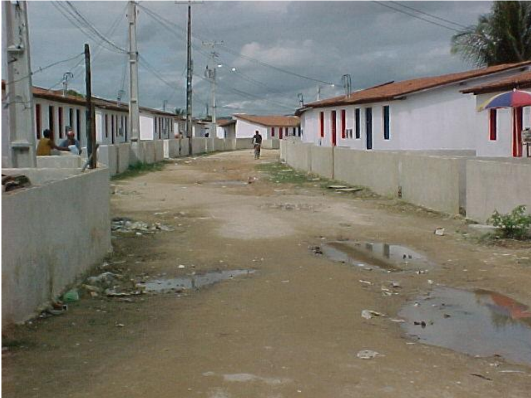
Foto 5 – Casas de alvenaria entregues em maio de 2003.
