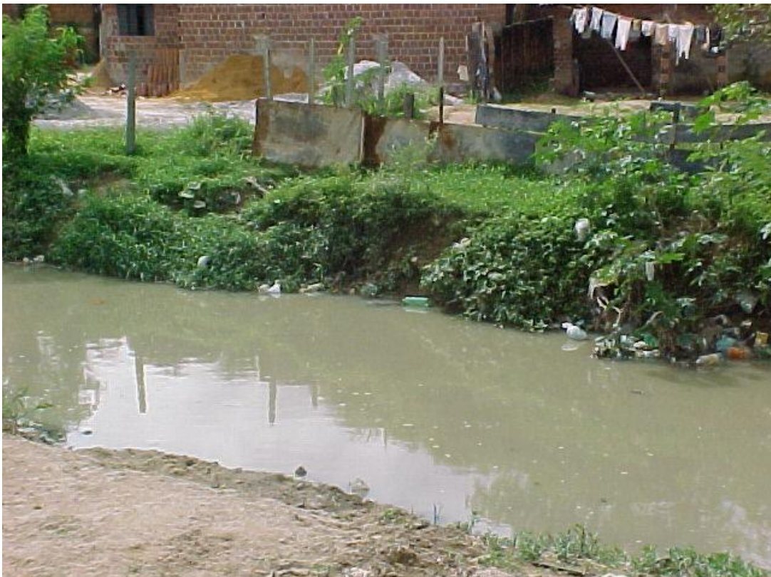
Foto 4 – Canal que passa dentro da Vila. Transborda mesmo com chuvas leves.
