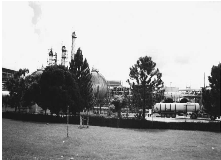
Foto 6 – Zona industrial. Vista da COPERBO. Marco referencial importante para a área urbana.
