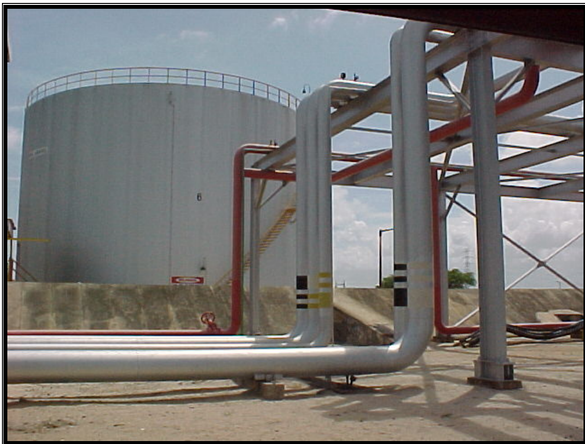
Figura 5 – Tanque n.º 6 do Terminal de Armazenagem Conjunta de Suape-PE
