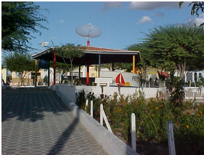
Figura 34 – Praça Arnaldo, no Centro de Poço Redondo/SE.
