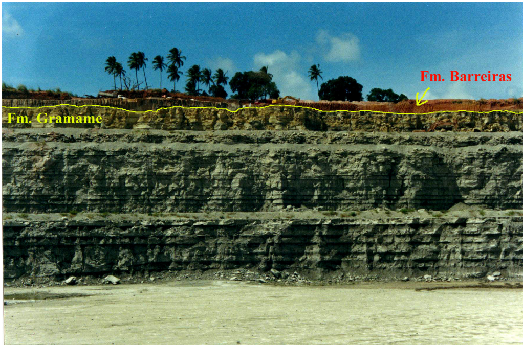
Foto V.5 - Vista geral das bancadas da Mina CIPASA. A camada de cor amarelada no topo da Formação Gramame, adquire esta cor devido ao processo de intemperismo provocado pela infiltração de água nas camadas superiores. Sobre a Formação Gramame, há depósitos da Formação Barreiras de cor avermelhada. A altura total dessas bancadas chega a ~41m. A partir de informações dos técnicos da mina, sabe-se que ainda existem mais de 7m de camadas calcárias abaixo do nível mais inferior visto na foto.
