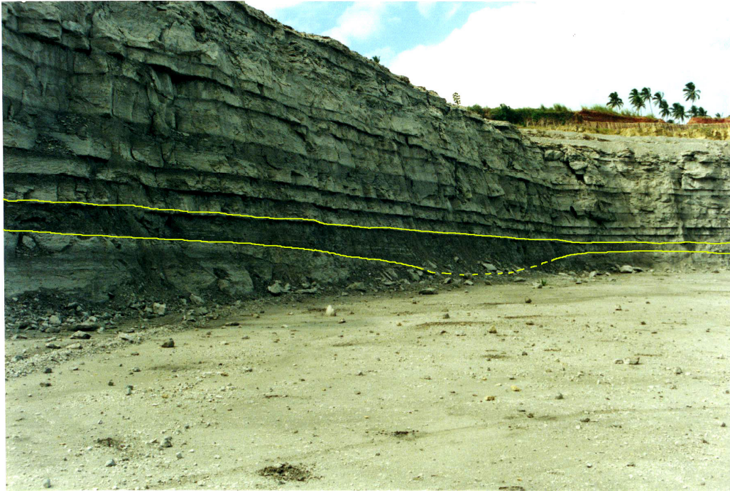
Foto V.3 - Outra vista da 1ª bancada da Mina CIPASA. Novamente aparece uma grande estrutura de escavação com mais de 8m de extensão (linhas amarelas). Notar que ,aparentemente, as camadas de calcários possuem um contato brusco com as camadas margosas, mais escuras. (altura da bancada = 10,5m).
