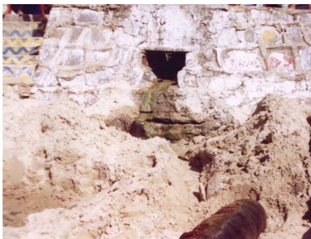
Canalização para a praia. (Trecho central de Porto de Galinhas)
