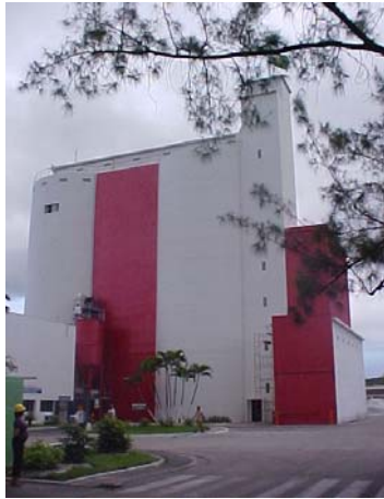
Figura 5.27c: O Caco de Vidro já Beneficiado é Acomodado nos Silos e Inicia a Reintegração do Caco ao Processo Produtivo através do Balanceamento a Composição.
