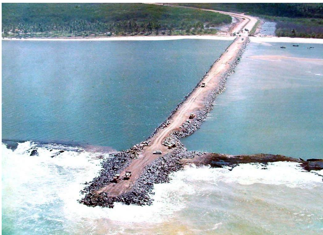
**Figura 4: Construção do molhe para a formação do porto externo.**
