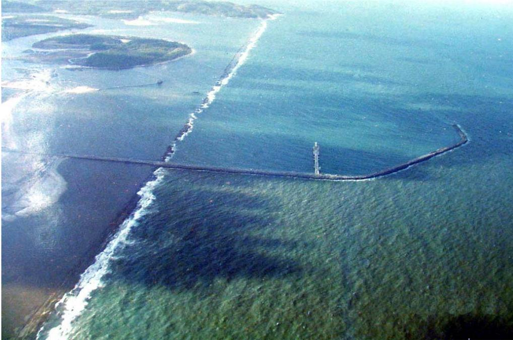
**Figura 5: Molhe do porto externo e píer de granéis líquidos<sup>1</sup>**
