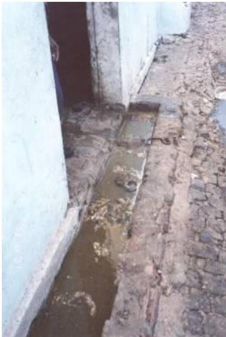
**Figura 4.6** - Vala de coleta e destinação de efluentes da sala de manipulação de vísceras, diretamente para o rio Ipojuca (matadouro de Ipojuca).
