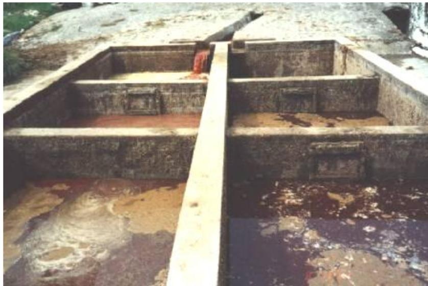
**Figura 4.8** - Dispositivo de retenção de sólidos e materiais flotantes (matadouro de Igarassú).
