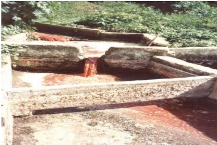
**Figura 4.5** - Dispositivo simplificado de retenção de sólidos e material flotante danificado (matadouro de São Lourenço).
