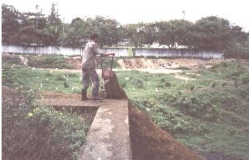
**Figura 3.5** - Descarte inadequado de material retirado da caixa de areia.
