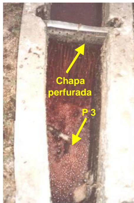
**Figura 3.4** - Sistema de gradeamento e ponto de coleta P3.
