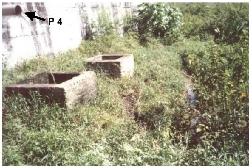
**Figura 3.7** - Detalhe da saída de efluente tratado da segunda lagoa anaeróbia, ponto P4 e da caixa de recebimento com o efluente percolando ao lado.
