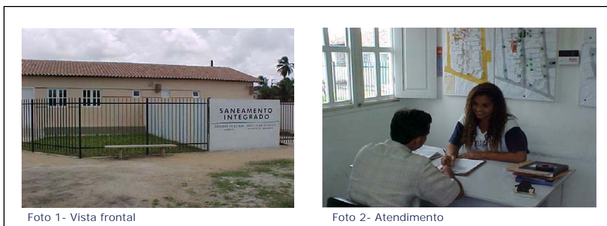
Figura 12- Escritório de Saneamento Integrado
