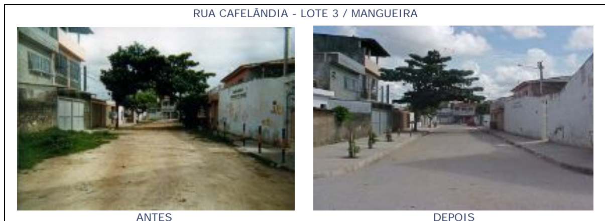
Figura 11- Obras realizadas Mangueira
