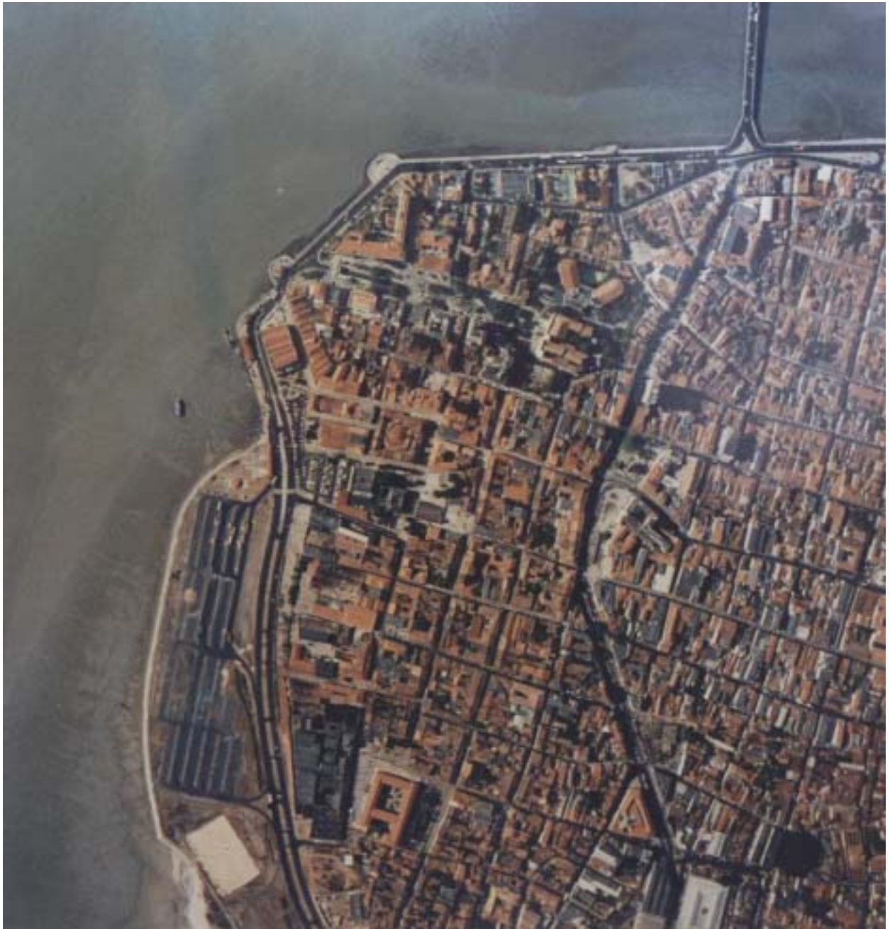
Figura 3.8 – Vista aérea do Centro Histórico mostrando o Aterro do Bacanga, margeando seu limite de Tombamento Federal
